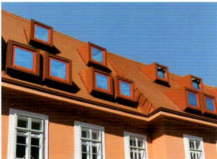
Denkmalschutz mal anders. Die modernen Dachgauben kontrastieren mit der Fassade. A new approach to historic building fabric: the modern eaves contrast with the façade.
